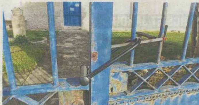
Le cadenas de la discorde, sur le portail permettant l'accès aux locaux de l'association, dans l'ancien presbytère.
